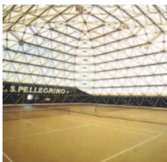
Pabellones polideportivos. Distribuye homogéneamente el calor en todo el ambiente
